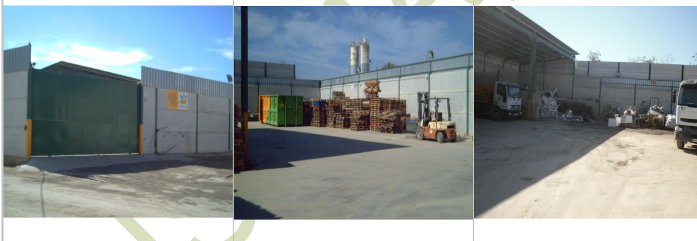
Planta de Recuperación de Residuos Inertes (Escombros y Maderas)
